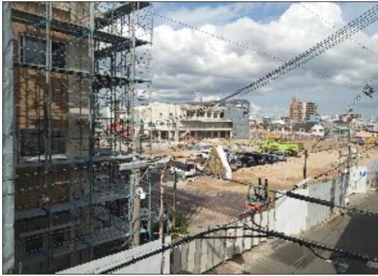
解体工事の始まった6中敷地
